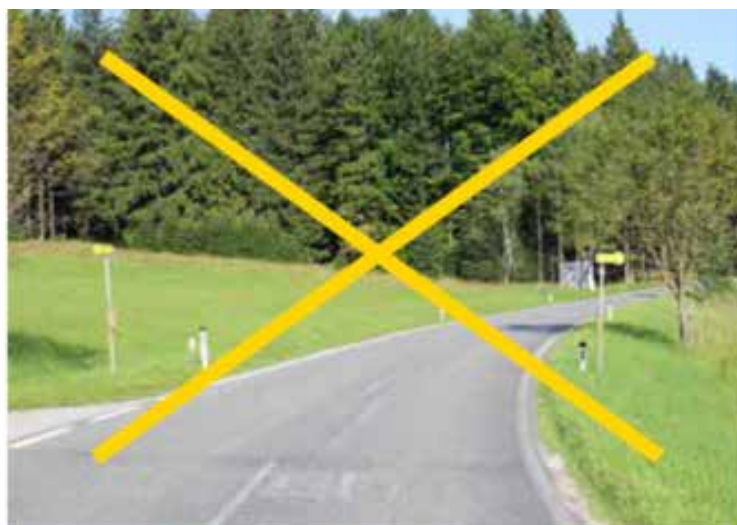
Haltestellen mit fehlender Auftrittsfäche entsprechen nicht dem Stand der Technik.
