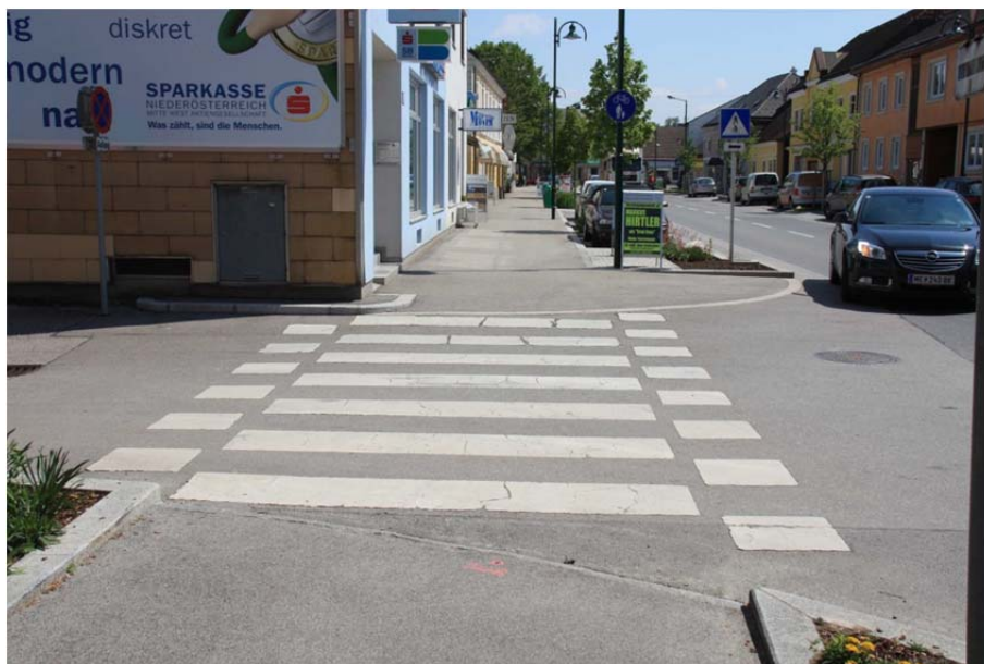
Abbildung 24: Auf der gegenüberliegenden Straßenseite wird der Radweg über die querende Straße mittels Radfahrüberfahrt geführt.
