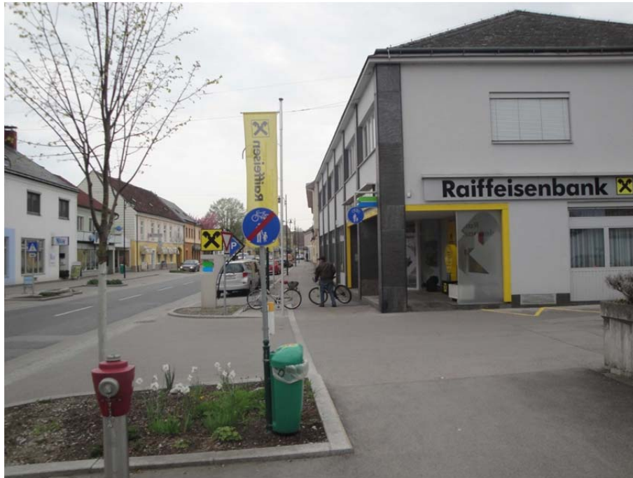
Abbildung 23: Unterbrochener Geh-/Radweg bei einer Ausfahrt. Die Benachrangung für den Radverkehr wirkt kontraproduktiv im Sinne der Verkehrssicherheit und der Zielsetzung zur Förderung des Umweltverbundes in der Marktgemeinde.
