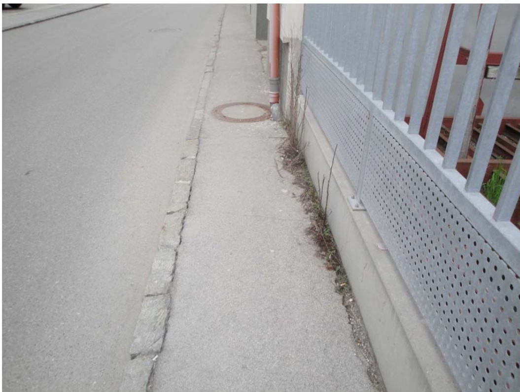
Abbildung 9: Unzureichende Gehsteigbreiten im Bereich Bahnhofstraße. Hier sind mindestens 2,0m anzustreben, um den Begegnungsfall Fußgänger-Fußgänger sicherzustellen.
