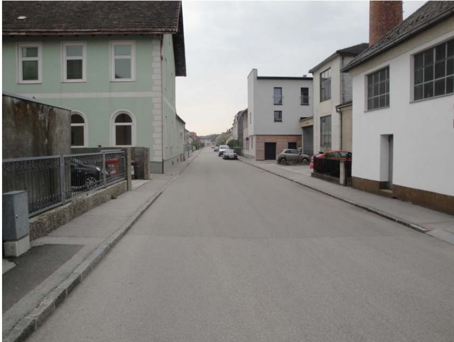
Abbildung 38: Bahnhofstraße: Verbesserungen für den Fußverkehr beim Zugang zum Bahnhof: Gehsteigverbreiterungen und Fahrbahnverschnenkungen zur Verkehrsberuhigung.
