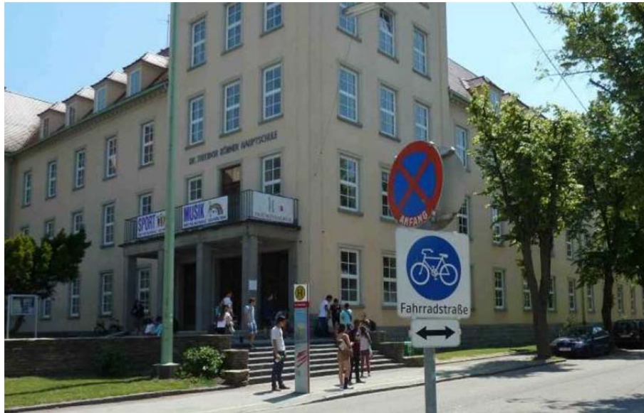
Abbildung 28: SHS St. Pölten, Johann Gasser-Straße: Fahrradstraße. 1
