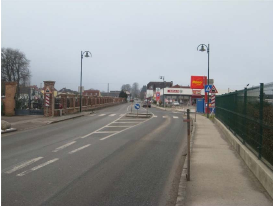
Abbildung 6: Mankerstraße Richtung Westen mit dem Zebrastreifen auf Friedhofshöhe. Man erkennt die schmalen Gehsteige auf beiden Seiten der Fahrbahn.
