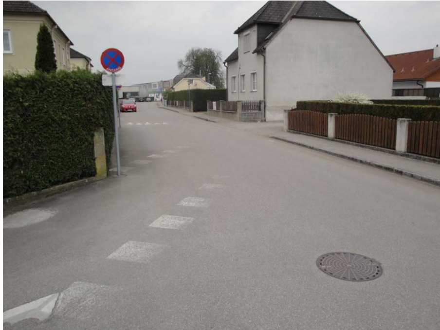
Abbildung 25: Radwegüberfahrt Austrasse/Raiffeisengasse. Diese wichtige Radwegverbindung zur Schule sollte zusätzlich rot eingefärbt und die Bodenmarkierungen erneuert werden.
